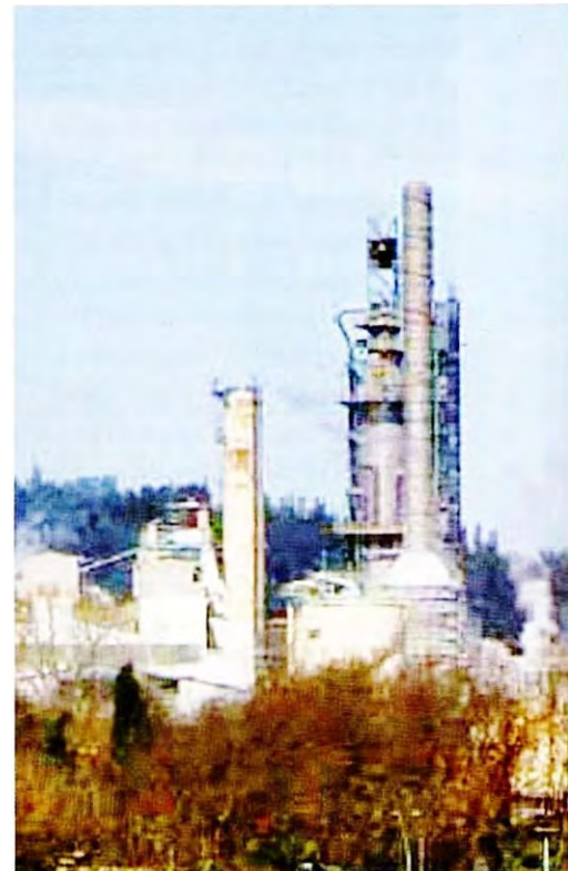
CMPC aprobó la construcción de dos calderas en base a biomasa e
