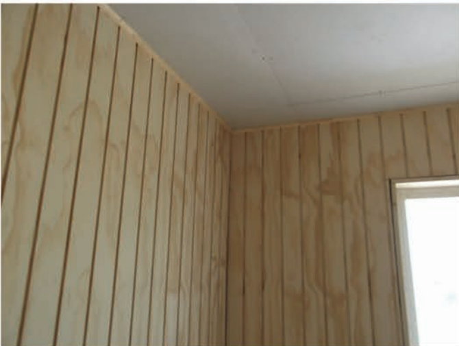
Encuentro de revestimiento muro y cielo.
