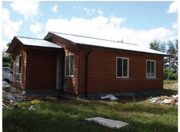
Vivienda terminada. Exteriormente se puede apreciar la instalación de tapacanes, forros alero, canal de agua lluvias y bajadas de agua.
