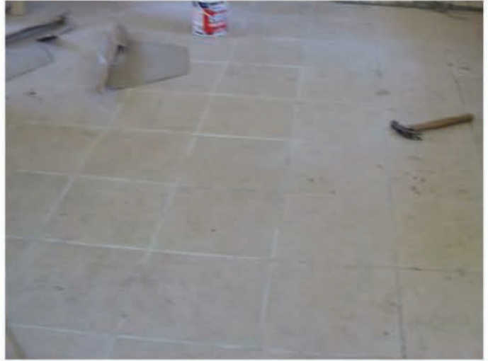
Terminación cerámica en piso living-comedor, cocina y baño.
