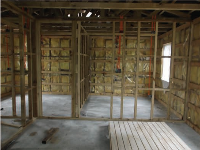
Estructura interior de tabiques.
