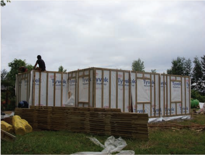
Terminada la instalación de muros y tabiques, se da inicio al montaje de la estructura de cubierta.
