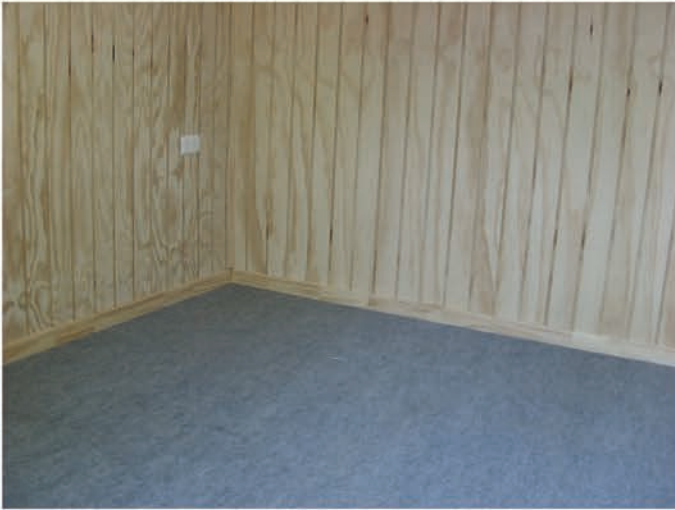
Terminación de cubre piso 3.5 mm en dormitorios.
