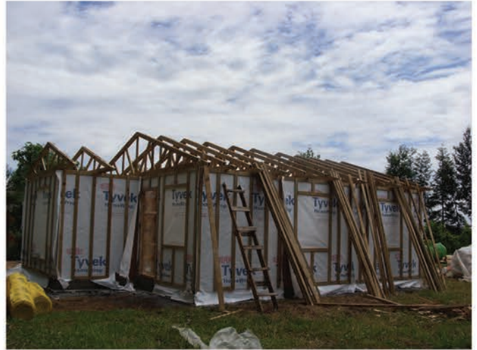
Las cerchas se unen a la estructura de muros y tabiques utilizando clavos de 4". A continuación se arriostran e instalan costaneras.
