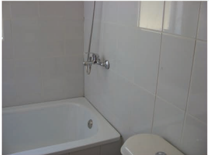
Terminación de muros en baño.
