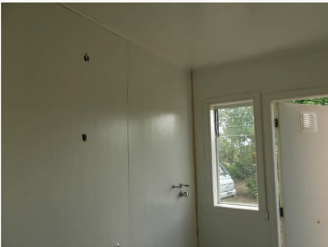
Terminación revestimiento de fibrocemento en muros, tabiques y cielo de cocina.
