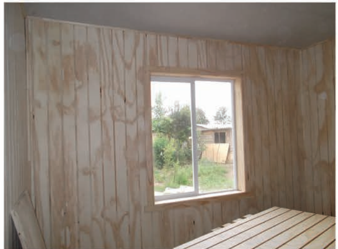
Ventana considera instalación de pilastras de madera.
