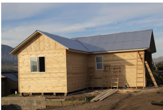
Figura N° 24 REVESTIMIENTO EXTERIOR TERMINADO
