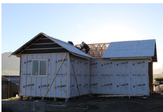
Figura N° 21 INSTALACIÓN TECHUMBRE ZINCALUM
