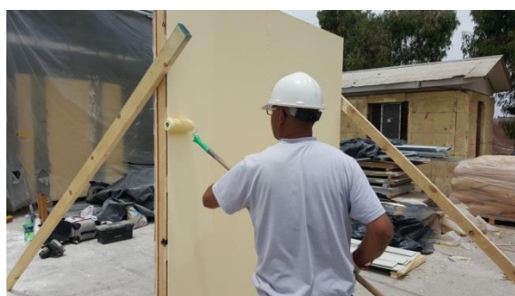
Figura N° 10 APLICACIÓN DE ENLUCIDO CON ESMALTE AL AGUA
