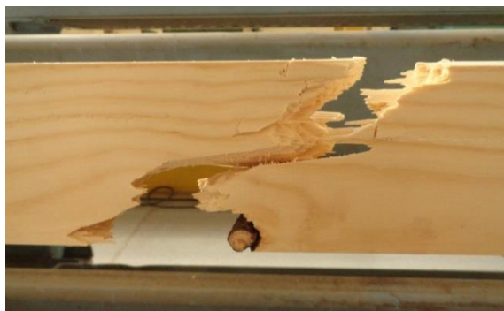
Figura N° 12 FALLA TÍPICA DE TRACCIÓN
