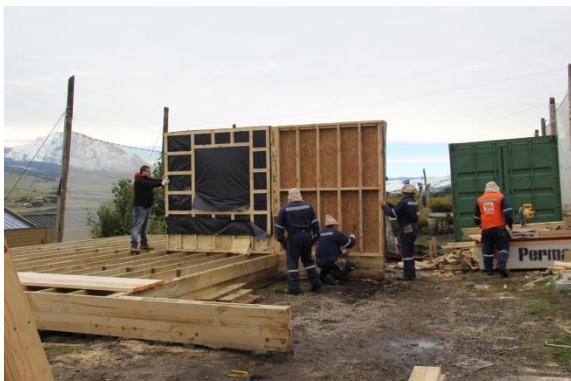
Figura N° 10 PRESENTACIÓN SEGMENTO DE MURO
