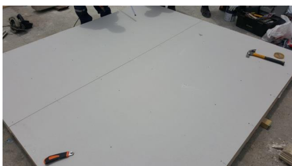
Figura N° 9 INSTALACIÓN DE PLANCHAS DE YESO CARTÓN DE 10 mm DE ESPESOR
