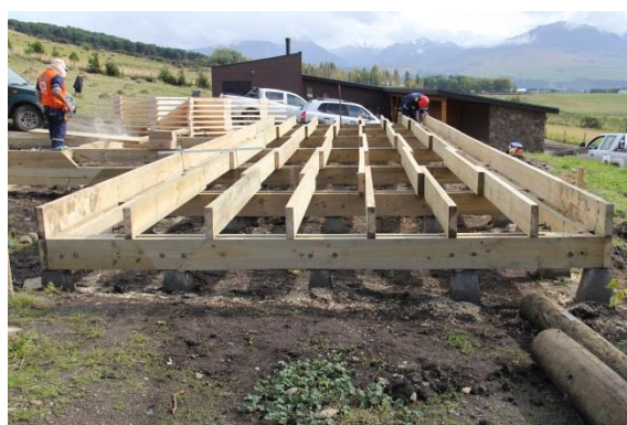
Figura N° 9 ENVIGADO DE PISO TERMINADO
