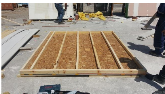
Figura N° 7 PLACA ARRIOSTRANTE EN ESTRUCTURA DE MADERA ASERRADA
