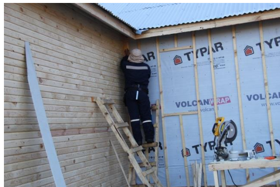
Figura N° 23 INSTALACIÓN REVESTIMIENTO EXTERIOR
