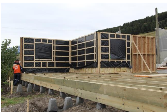
Figura N° 14 SEGMENTOS DE MURO INSTALADOS
