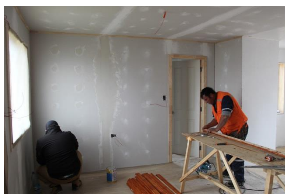
Figura N° 27 REVESTIMIENTO INTERIOR TERMINADO
