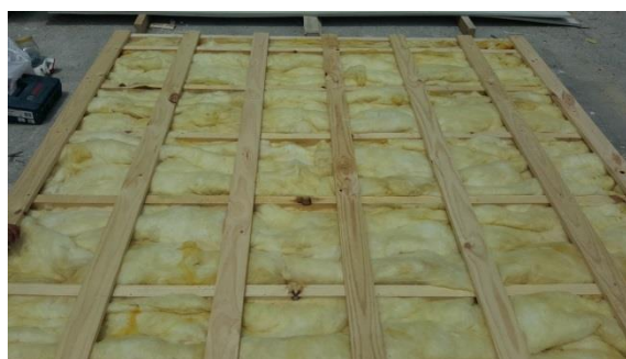
Figura N° 8 SEPARADORES HORIZONTALES Y LANA MINERAL (CARA INTERIOR)
