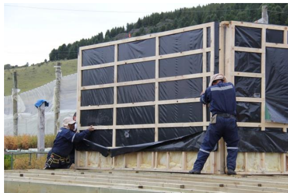
Figura N° 11 MONTAJE SEGMENTE DE MURO
