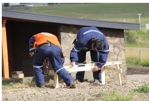
Figura N° 3 NIVELACIÓN DE TERRENO
