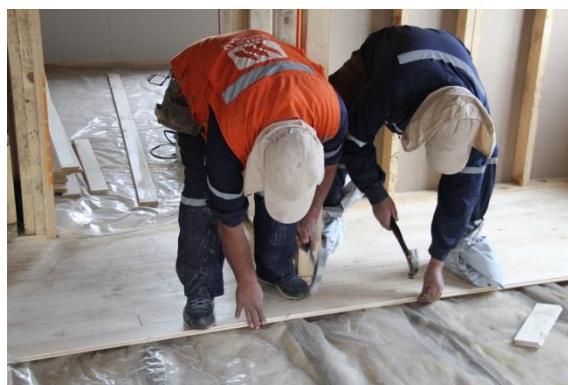
Figura N° 25 INSTALACIÓN PISO MADERA
