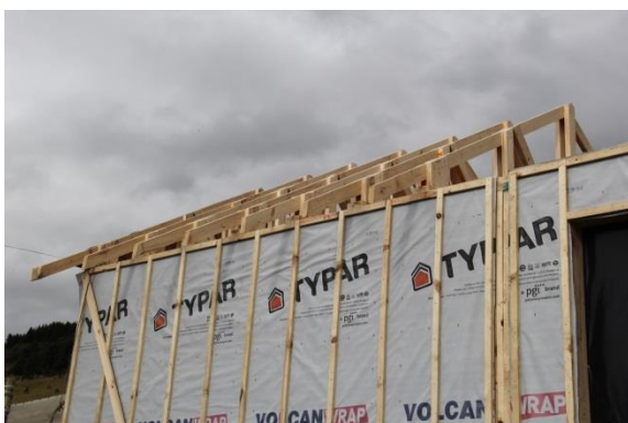
Figura N° 18 CERCHAS INSTALADAS
