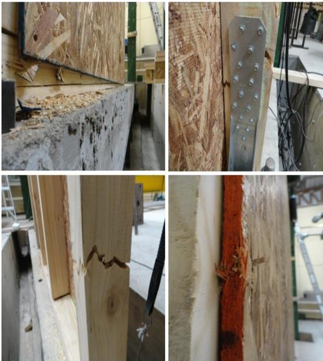
Figura N° 8 FALLAS CARACTERÍSTICAS DE MUROS SOMETIDOS A CARGA LATERAL EN LME-INFOR
