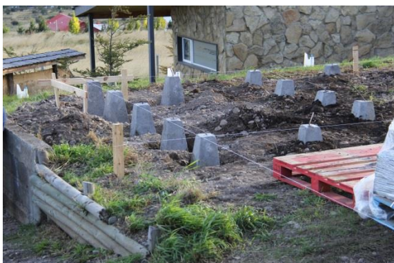
Figura N° 4 INSTALACIÓN DE POCHOS DE HORMIGON
