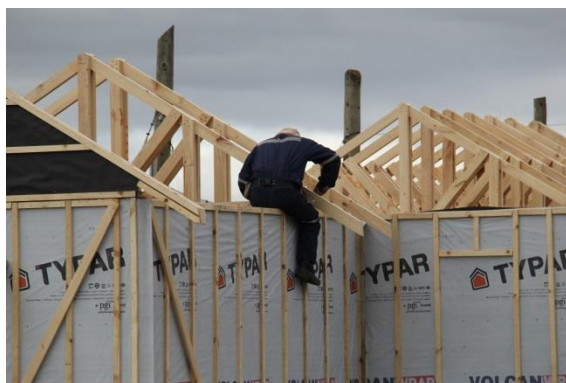
Figura N° 17 INSTALACIÓN CERCHAS
