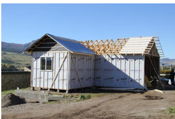
Figura N° 20 INSTALACIÓN TECHUMBRE ZINCALUM
