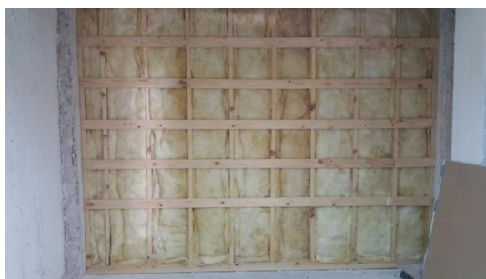
Figura N° 2 SEPARADORES HORIZONTALES Y LANA MINERAL (CARA INTERIOR)
