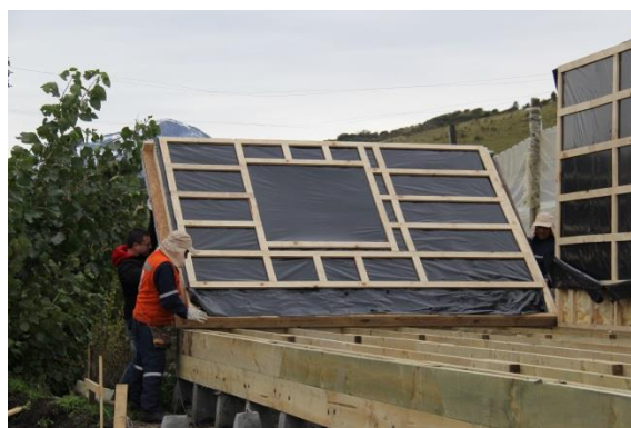
Figura N° 13 MONTAJE SEGMENTO DE MURO
