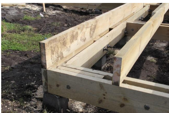
Figura N° 8 MONTAJE ENVIGADO DE PISO
