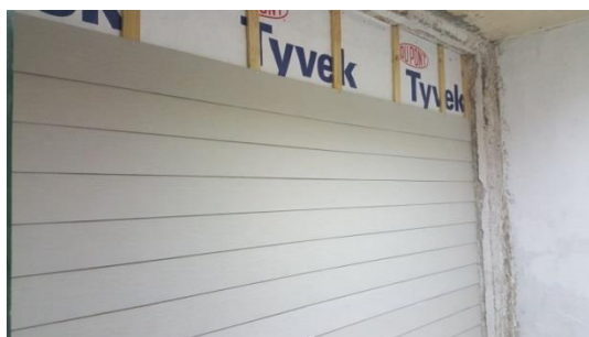
Figura N° 4 INSTALACIÓN DE TERMINACIÓN EXTERIOR SIDING TINGLADO
