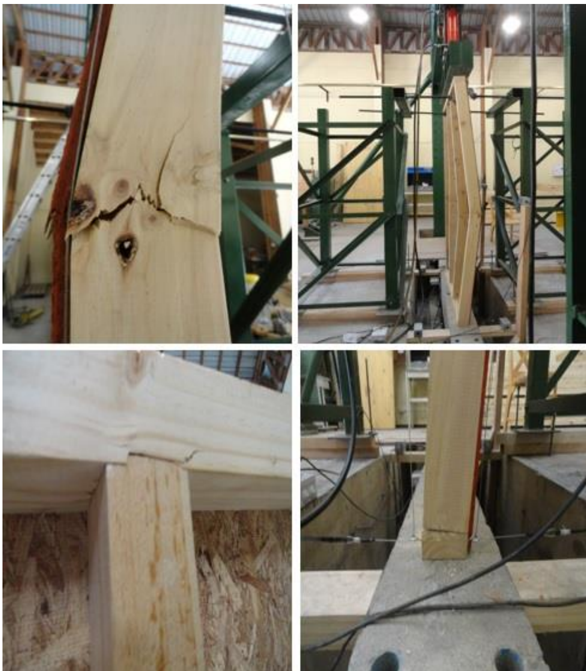
Figura N° 13 FALLAS CARACTERÍSTICAS ENSAYOS DE CARGA VERTICAL DE MUROS ESTRUCTURALES EN LME-INFOR
