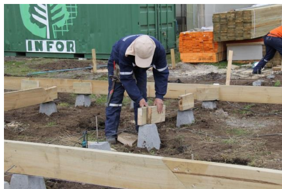
Figura N° 5 PREPARACIÓN POCHOS PARA ENVIGADO DE PISO
