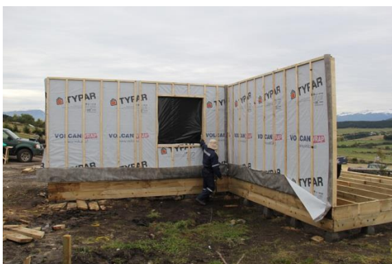
Figura N° 12 INSTALACIÓN MEMBRANA HIDRÓFUGA
