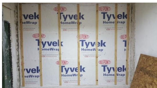
Figura N° 3 SEPARADORES VERTICALES Y BARRERA DE HUMEDAD TYVEK
