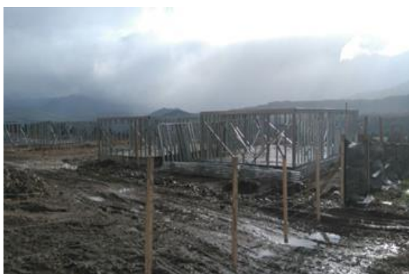
Figura N° 33 ARMADO DE METALCOM VIVIENDA SOCIAL EJERCITO SUR DE CHILE
