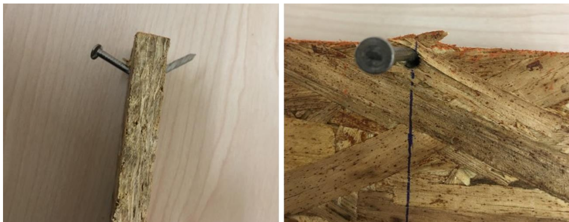
Figura N° 13 FALLA EXTRACCIÓN LATERAL DE CLAVOS
