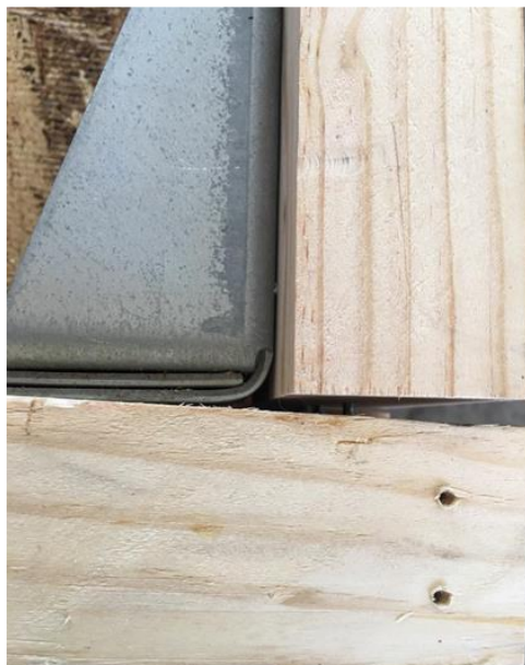
Figura N° 11 DESCLAVADO DEL PIE DERECHO
