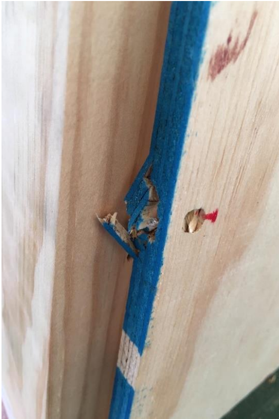
Figura N° 9 FALLA POR APLASTAMIENTO LOCAL DEL TABLERO CONTRACHAPADO
