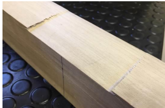
Figura N°16 COMPRESIÓN NORMAL FALLA POR APLASTAMIENTO LOCAL
