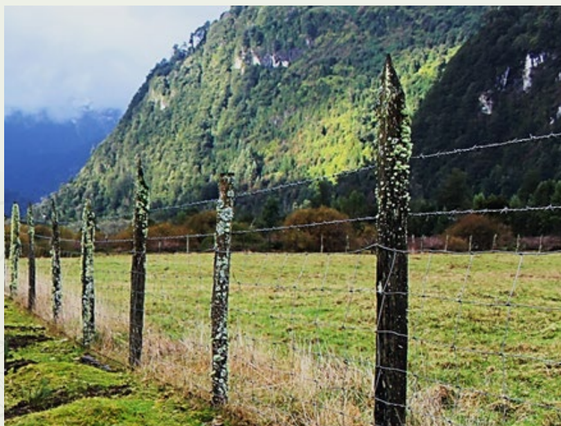
Figura 18. Cerco para ovejas, cabras o cerdos. El cercado se realizó con malla Ursus 832, con dos hebras de alambre de púas y estacas de madera nativa.
