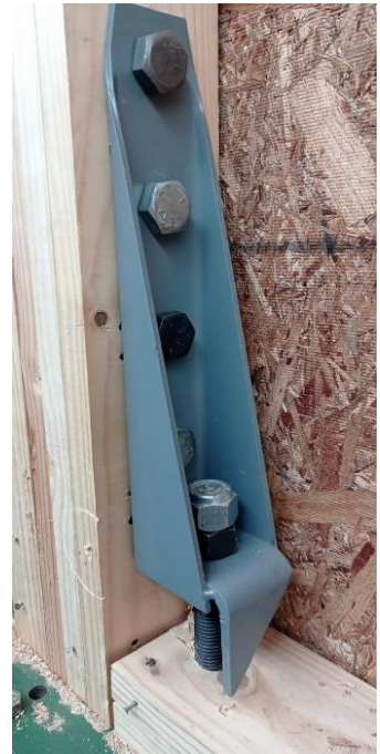
Figura N°3 CONECTOR UTILIZADO EN EL ANCLAJE
