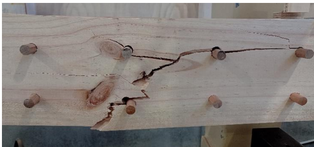
Figura N° 15 Falla típica en flexión laminación continua
