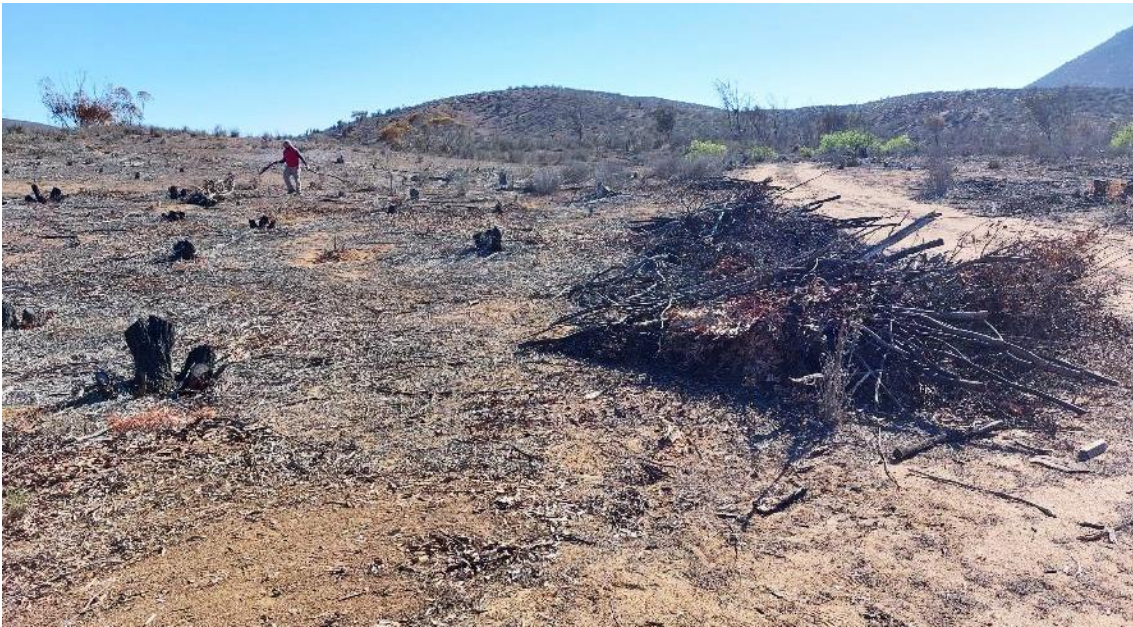
Figura 16 LABOREO PARA LA IMPLEMENTACIÓN DEL ÁREA A RESTAURAR
