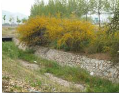
Foto 28: Espinos plantados en taludes de canal.
