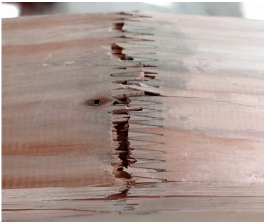
Figura N° 11 FALLA TÍPICA EN LA BASE DEL DIENTE
