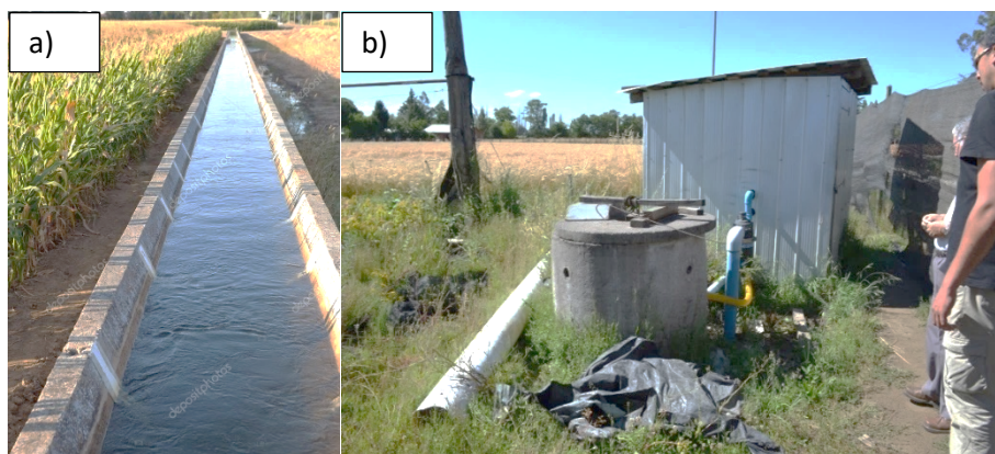
Figura 1. Captación de agua superficial (a) y subterránea (b).
