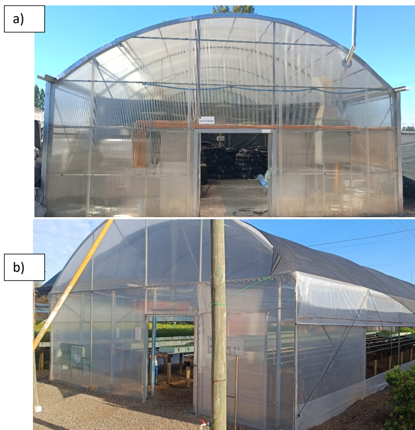
Figura 18. Invernaderos construidos en estructura galvanizada con cubierta de policarbonato (a) y polietileno (b).
