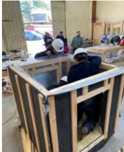
Construcción módulo de madera
