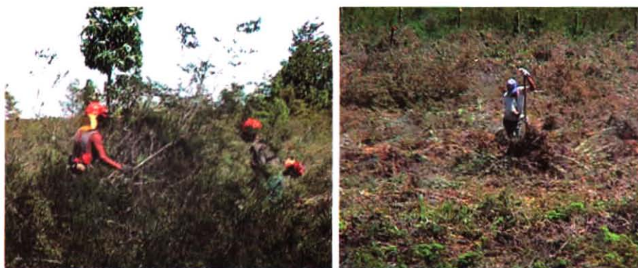
Figura N° 69. Limpia del terreno
