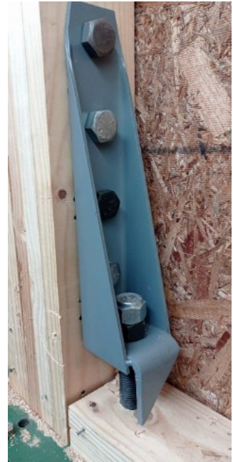
Figura N°6 CONECTOR MURO FUNDACIÓN
