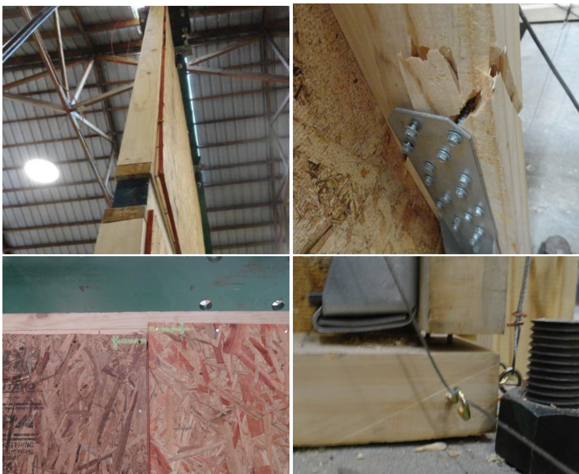
Figura 2.5: Modo de falla característico de ensayo de carga horizontal en muros con estructura de madera de doble altura.
