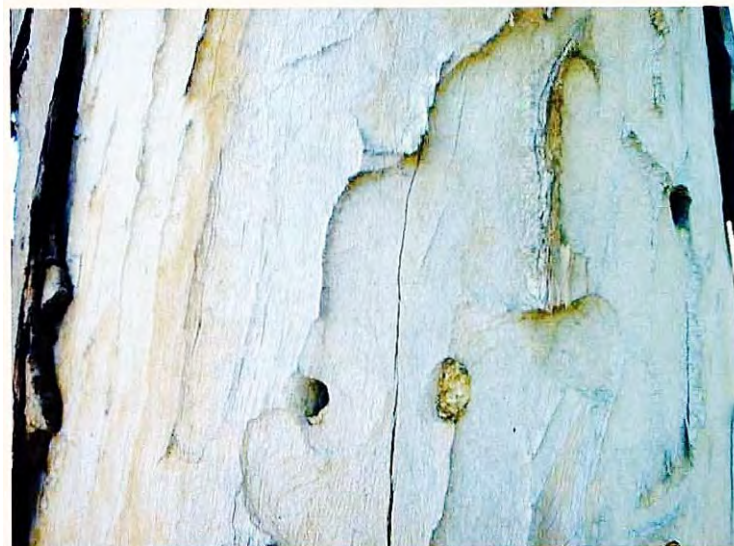
Daño por orificios de salida del insecto.
