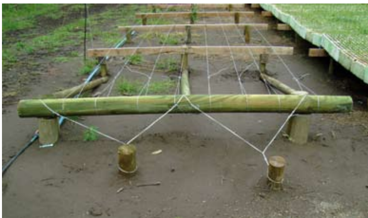
Figura 1.4. Mesón porta bandejas construido con postes impregnados, tapas de pino y alambre N° 12.
