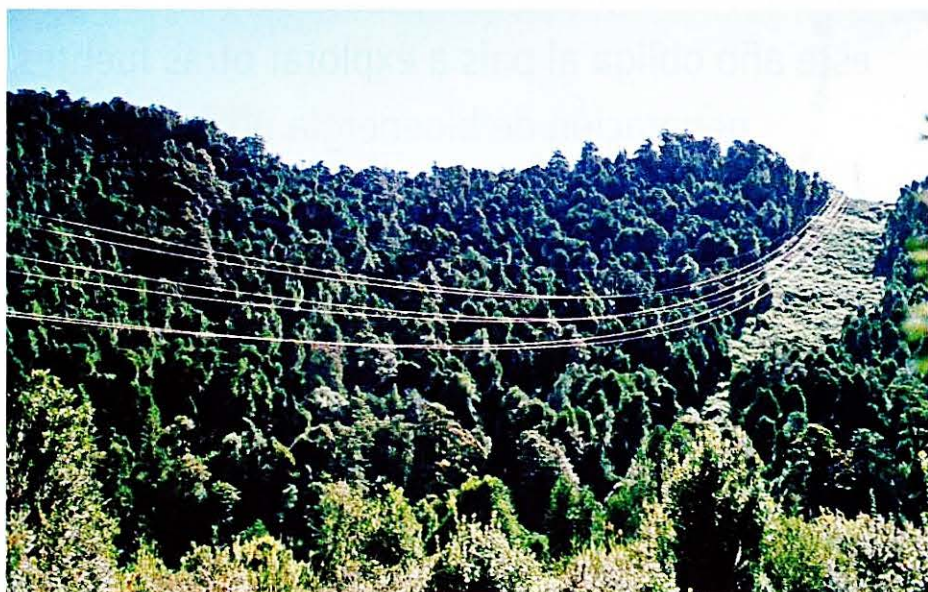
► Generación eléctrica en el bosque nativo.
