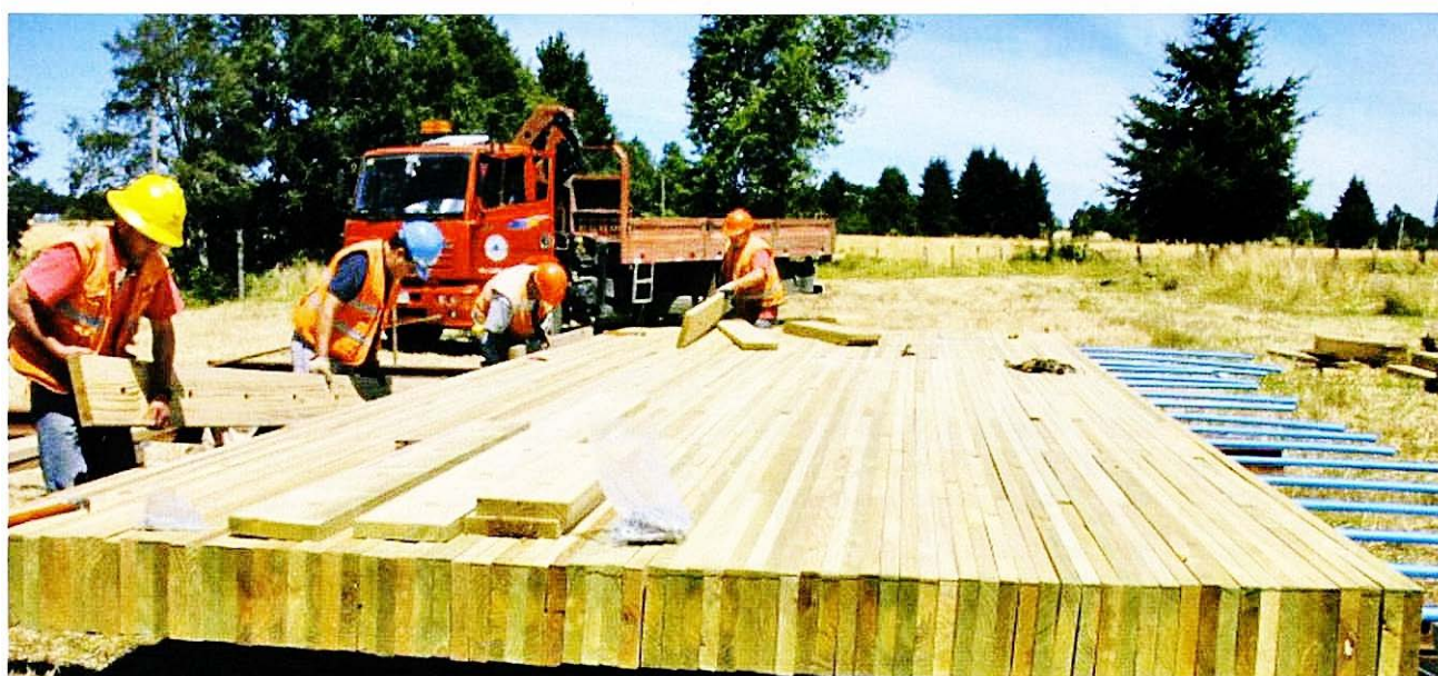
El Puente Caulín es el primer puente de alto tráfico de Chile y el más largo de Latinoamérica elaborado con esta tecnología.
