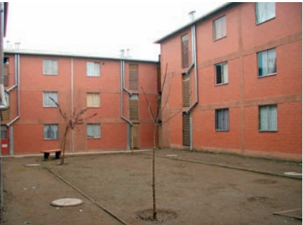
Ausencia de actividad y control en el espacio
