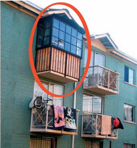
Elementos distintivos: cerramiento de balcón
