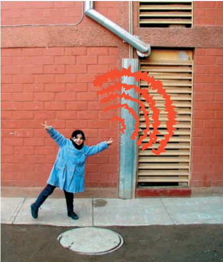
Paso de ruido desde el exterior a través de loggias
