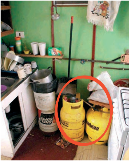
Problemas para almacenamiento de combustible
