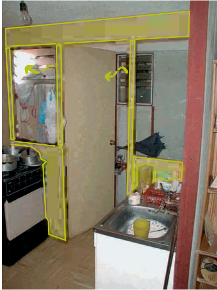
Ventilación de baño a loggia
