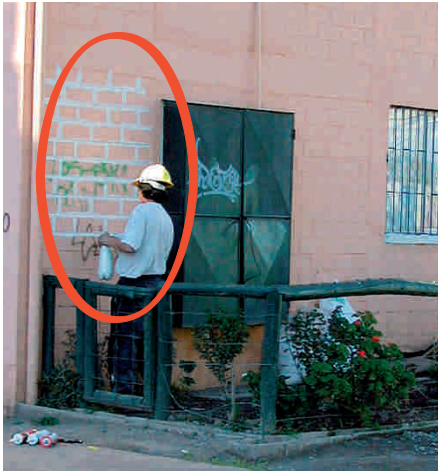
Impermeabilización de fachadas por problemas de humedad
