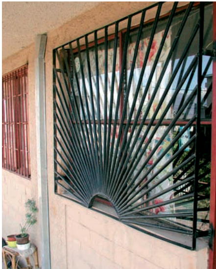
Rejas como elementos de seguridad e identidad
