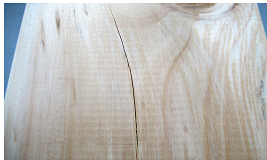
Grieta de secado
