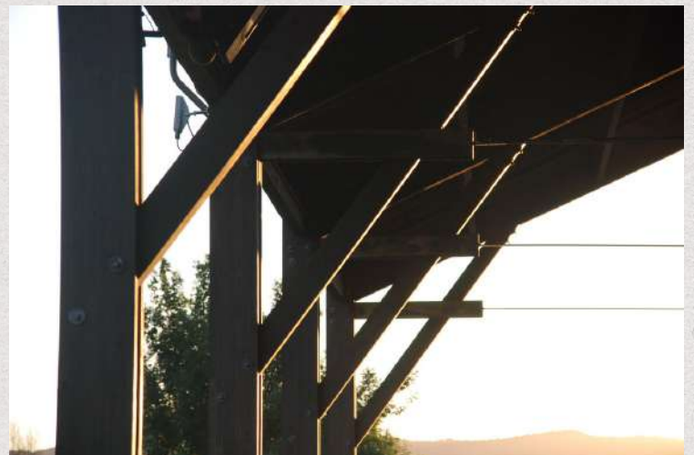
UNIÓN DE MOMENTO CON PERNOS, UNIÓN EN CEPO ENTRE VIGA Y PILAR
