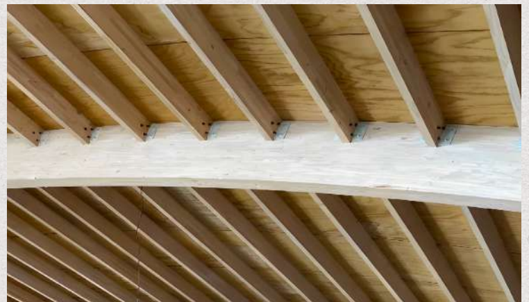
COSTANERAS UNIDAS CON SOPORTES DE ACERO OCULTOS A VIGAS
