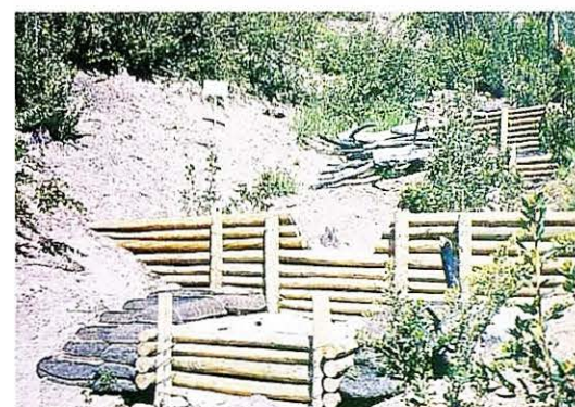
Control de erosión de áreas afectadas por incendios forestales, mediante diques de madera, en Sierras de Bellavista, VI Región.
