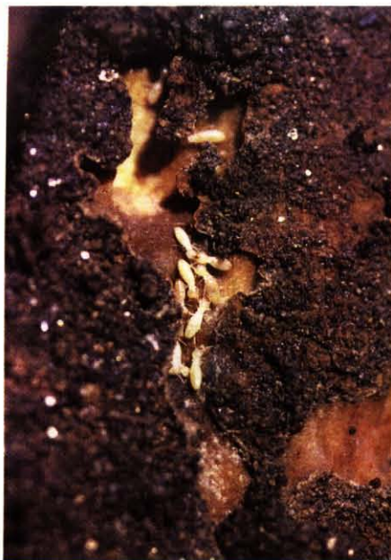
Figura 9 : Galería de termitas subterráneas.
