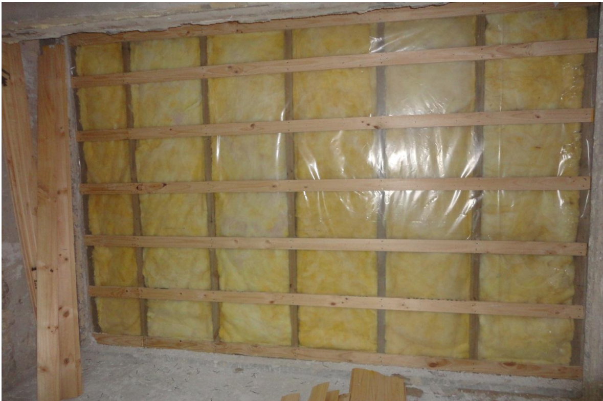
(b) Instalación de separadores horizontales sobre la barrera de vapor (cara interior)
