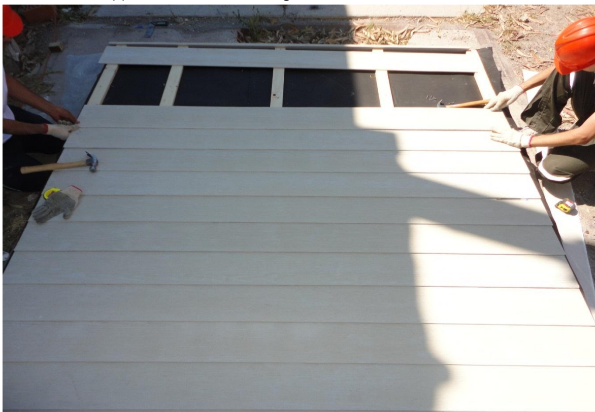
(d) Instalación de fajas de fibrocemento como revestimiento exterior.
