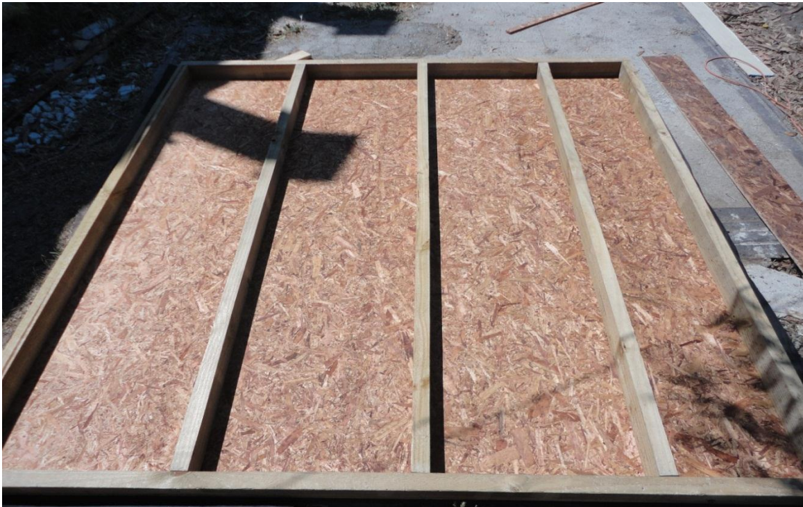
(a) Conformación de la estructura del muro con pie derechos y placa arriostrante.
