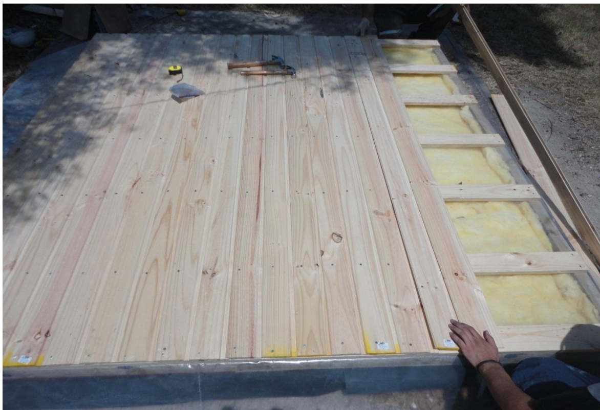
(c) Instalación de madera tinglada como revestimiento interior.
