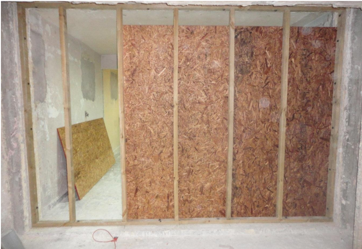
(a) Instalación de placa arriostrante OSB en la estructura de madera aserrada
