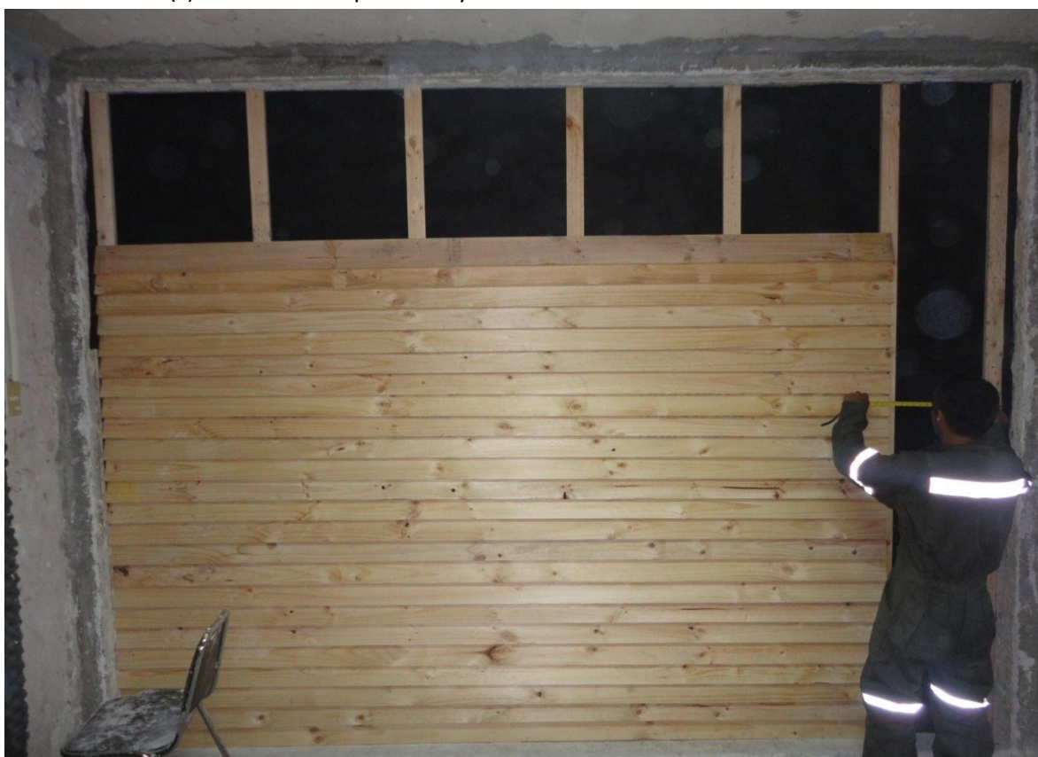
(d) Instalación de fajas de madera cepillada como revestimiento exterior
