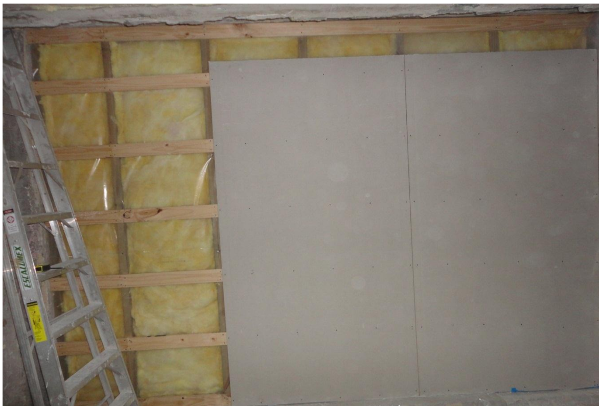
(c) Instalación de placas de yeso-cartón como revestimiento interior
