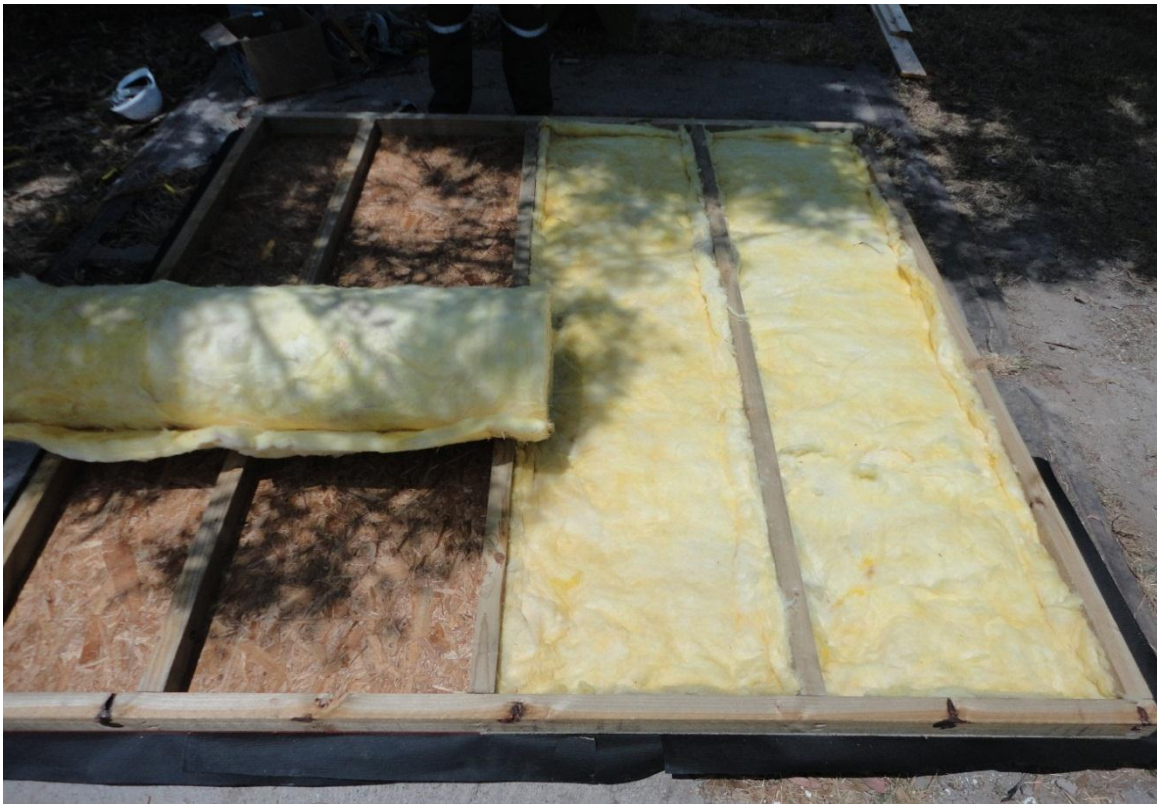
(b) Instalación de lana de vidrio como material aislante térmico.
