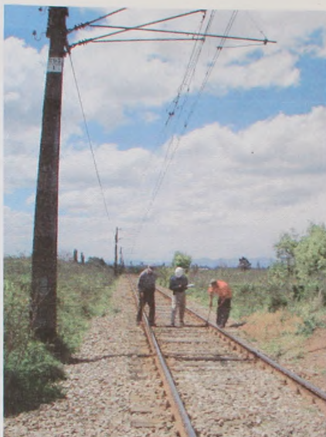
Foto 1. La fotografía captada en el kilómetro 203, poste 1, zona Molina, muestra el equipo de trabajo formado por un inspector y dos ayudantes.
