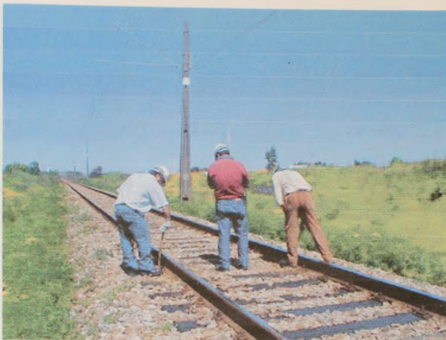
Foto 5. . La fotografía captada en el kilómetro 229, zona San Rafael, muestra el equipo de trabajo que participó en la inspección y el estado general de la vía en esa zona.
