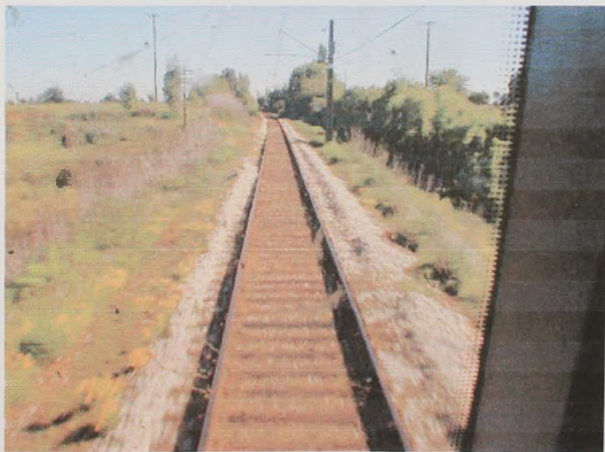
Foto 10. En el corredor se visualiza balasto dejado al lado de la vía para realizar mantención de la superestructura.
