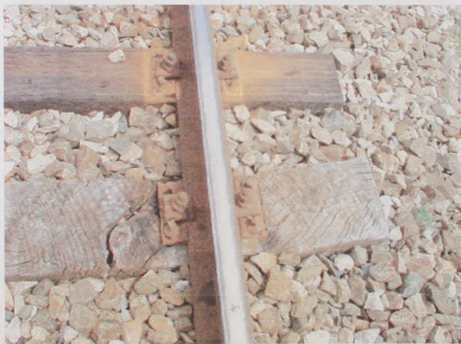
Foto 4. En la zona de San Rafael se encontró un durmiente sin impregnación, quebrado en la zona de la silla de asiento.
